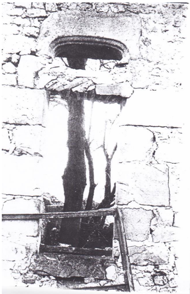
Le linteau de fenêtre encore en place
