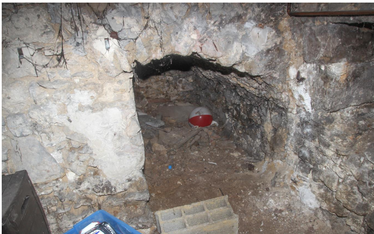
Accès au petit caveau
