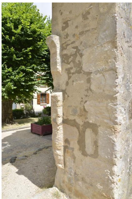
1 jambages de porte nord
