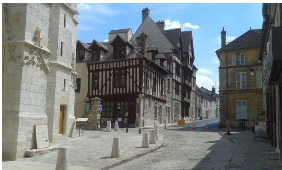
La réhabilitation des maisons du Logis du Bon Saint-Jacques
