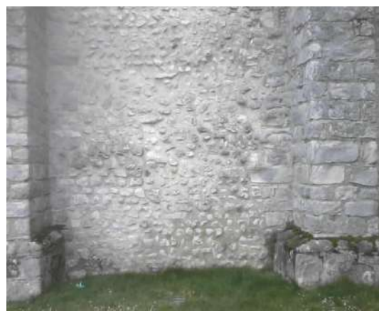
Arc de décharge et opus spicatum, mur sud de la nef
