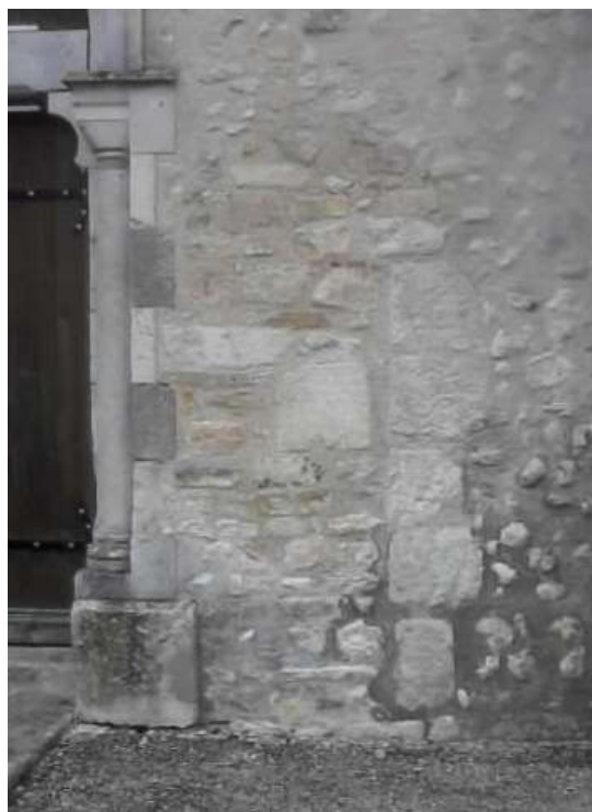
Vestige d'une porte murée dans la façade occidentale
