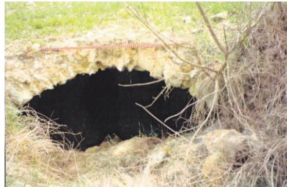
Le « petit tunnel » à Dormelles
